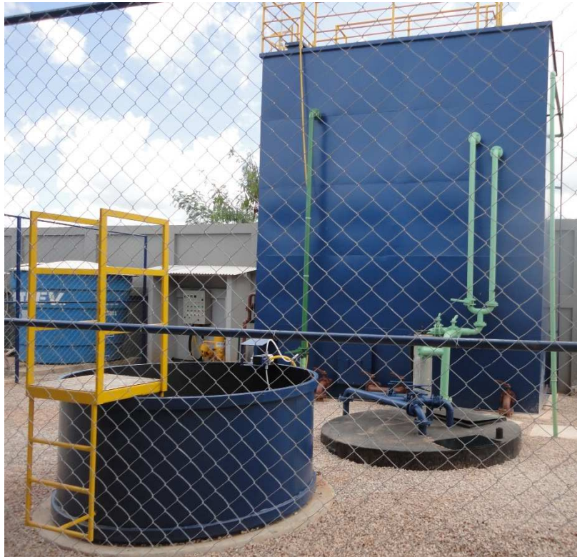
Figura 16. Dique de contenção do coagulante.
