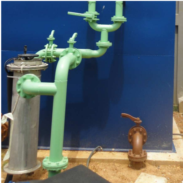
Figura 20. Reator ultravioleta da estação.
